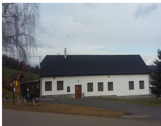
Stav po dokončení realizace:
